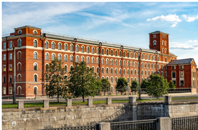
Наб. Обводного канала, д. 60
